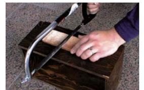
※平で納まらない部分へは、平を「スレート用ノコ」または「ディスクサンダー」で切断して施工して下さい。超軽量材のため、容易に切断加工できます。
