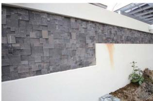
石材から、汚れ、灰汁、錆などが流れ出る場合があります。ジョリパット仕上げの門柱にライン状に施工する場合、壁面を汚損する可能性がありますので、必ずジョリパット面には撥水コート仕上げをするなど、汚損防止対策をして下さい。万一、汚れた場合は「アクトル」「アクロン」「トーレス」などを用いて綺麗にしたのち、撥水コートで再度表面を仕上げして下さい。
