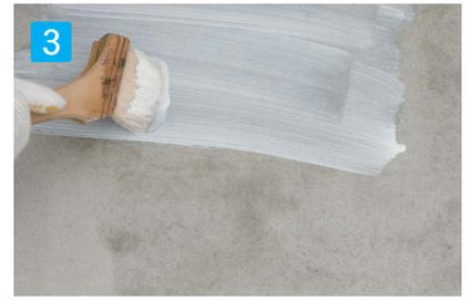
3 接着専用プライマーを刷毛で塗布して下さい。
