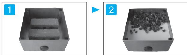
ボックス内部にレンガなどの高さ調整材を置きます。
