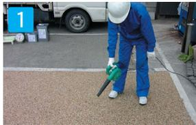
1 施工場所の表面のゴミ・汚れを除去して下さい。汚れのひどい場合は、デッキブラシ等で水洗いし乾燥させてから施工して下さい。
