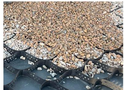
本製品施工後、上の部分は砂利面より下にして下さい。
