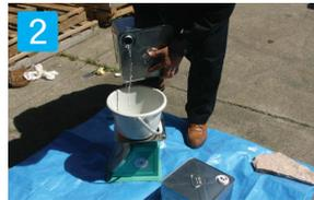
2 トップコートゝ施工面積に合わせて主剤と硬化剤を計量し、十分に混ぜ合わせて下さい。混合比は、主剤：硬化剤が1：1です。
