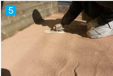
7 ウィーガード/ウィーガード御影を敷き均す。飛散した材料が付着しないように周辺を養生して下さい。木コテ・プラスチックコテで均し押さえて下さい。(平らに整地する程度、押さえすぎると施工厚が40mm以下となり、透水性・保水性が低下します。)
