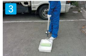
3 トップコートがローラーに多量に付着しないようにローラーを「シコキ」ながら作業して下さい。
