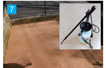
9 1次散水 噴霧器等(出来るだけ霧状)を使って、全体をやさしく均一に散水して下さい。シャワーホース等で勢い良く散水すると色粉が沈んでしまい、施工不良となります。清水(水道水)を使用して下さい。水量は表面が濡れる程度。散水時の足跡はほうきで均しながら順次散水して下さい。 ※整地した表面が崩れないように全体を濡らして引き締める程度、散水量が多過ぎると固化材が流出し、骨材表面の露出により本来の仕上がり時の色調と異なりますのでご注意下さい。(P16の「固化材が流出した仕上がり」画像をご参照下さい)
