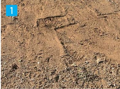
路床等の路盤は十分な転圧を行い、破片、岩を取り除いて、不陸な部分を調整して下さい。
