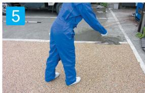
5 トップコートは、塗布後15分～20分(外気温25℃として)で乾燥してしまいますので、塗布作業は2～3㎡目安に順次ノンスリップ材を散布して下さい。
