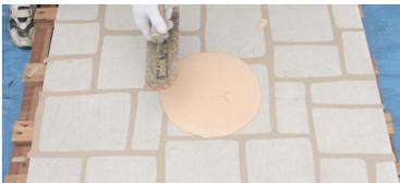
ベースカラー(ビーチN)の塗り込み後、速やかにアクセントカラー(テラコッタN)を塗布して下さい。ベースカラーの表面が乾いてしまうとアクセントカラーが密着せず施工不良になりますのでご注意下さい。施工には別売のアクセントカラー専用施工キットを使用すると塗布しやすくなります。
